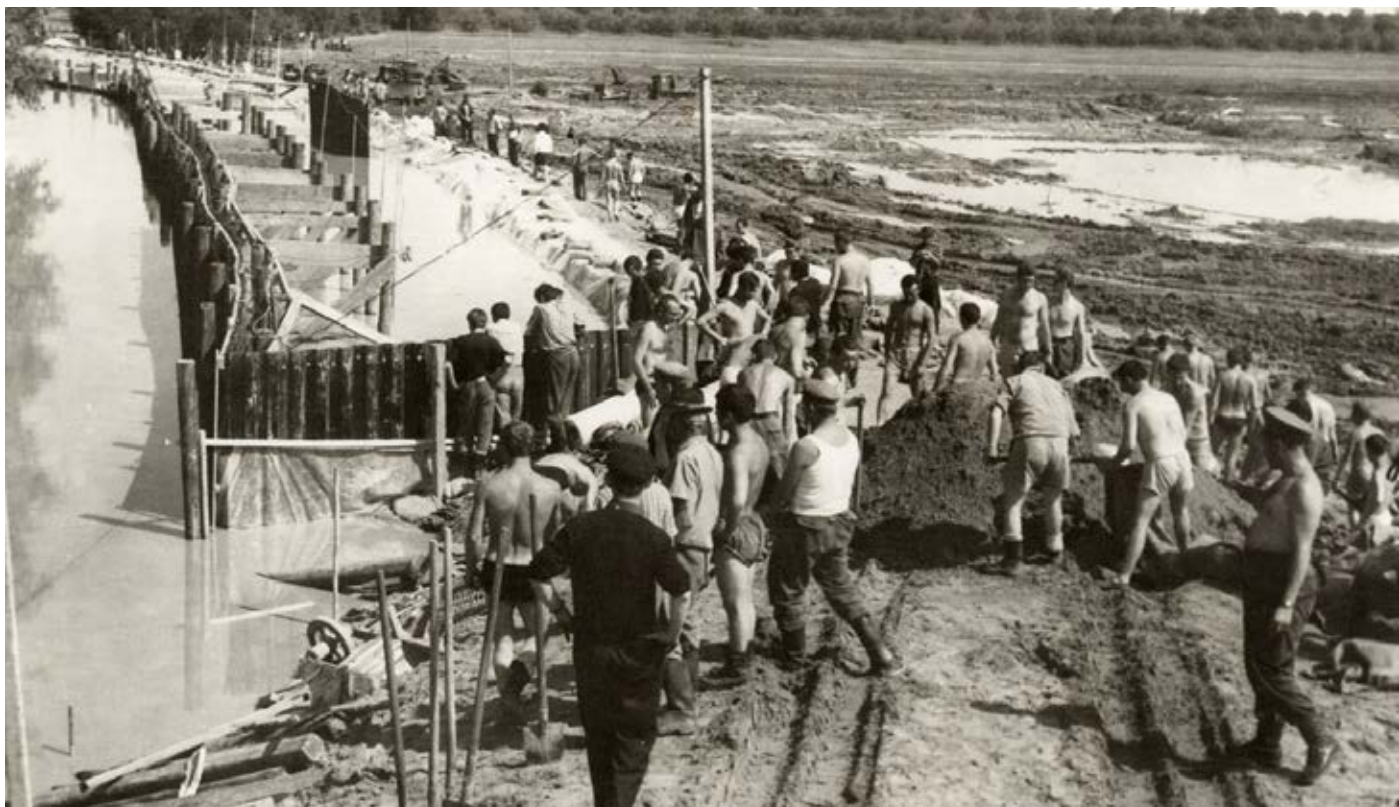
19. kép. A Szamos tunyogmatolcsi töltésszakadásának ideiglenes elzárása (1970. június)
