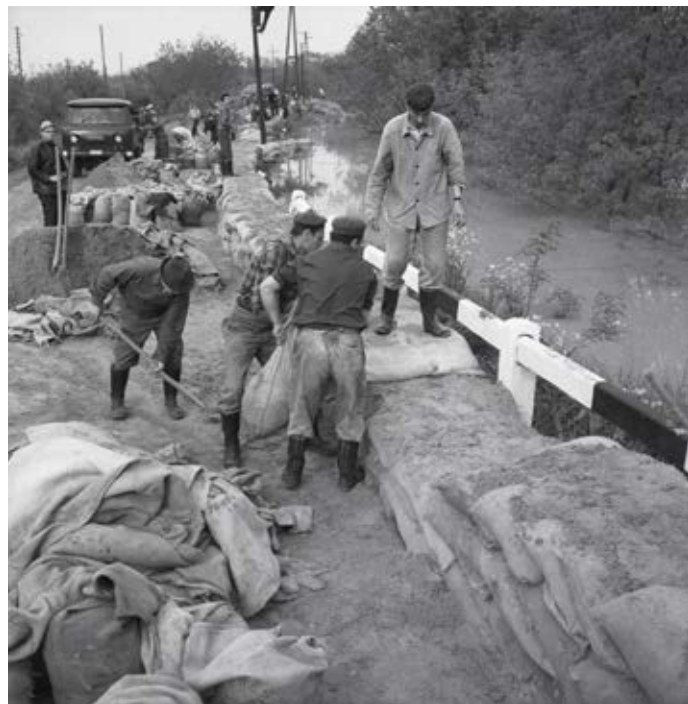
22 kép. A Fehérgyarmat-Túnyogmatolcs közötti kőzút megerősítése ideiglenes lokalizációs töltésként (1970.05.16.) (A Duna Múzeum gyűjteményéből)
