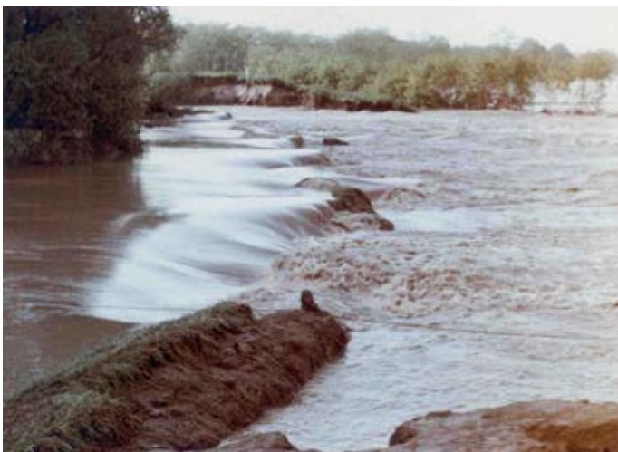
8. kép. A Szamos egyik nábrádi töltésszakadása kifejezett állapotban (1970.05.17.)
