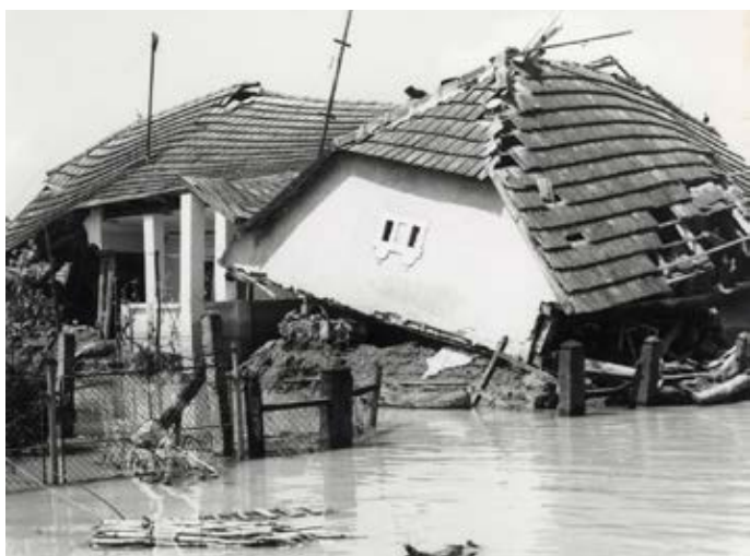
27. kép. Az árvíz pusztítása (1)
