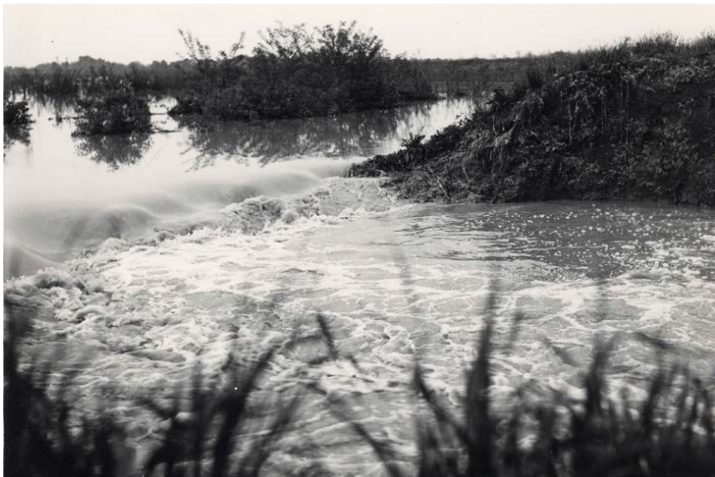
1. kép. Szakadás a Túr töltésén Garbolcnál (1970. 05. 14.)
