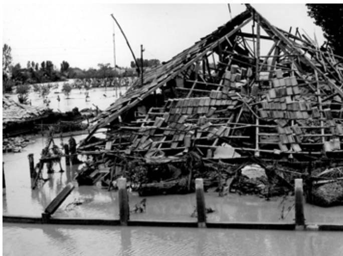
29. kép. Az árvíz pusztítása (3)
