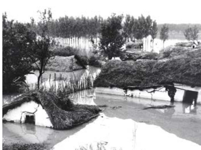
31. kép. Az árvíz pusztítása (5)
