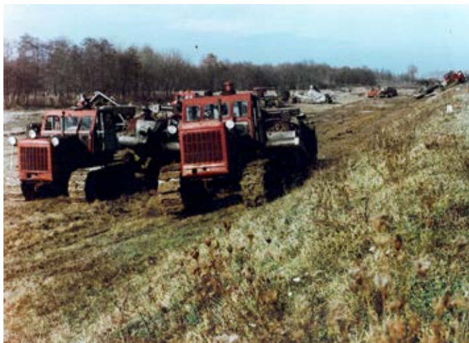
41. kép. Épül a Szamos-Túr közti zárógát (1) (1970)
