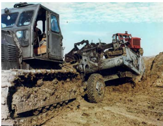
42. kép. Épül a Szamos-Túr közti zárógát (2) (1970)
