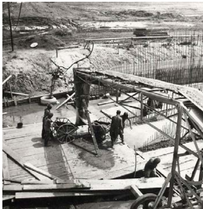
44. kép. Zsilip építés Komlódtótfalunál (1970)
