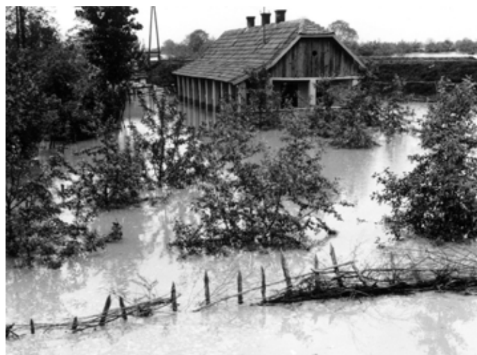
28. kép. Az árvíz pusztítása (2)
