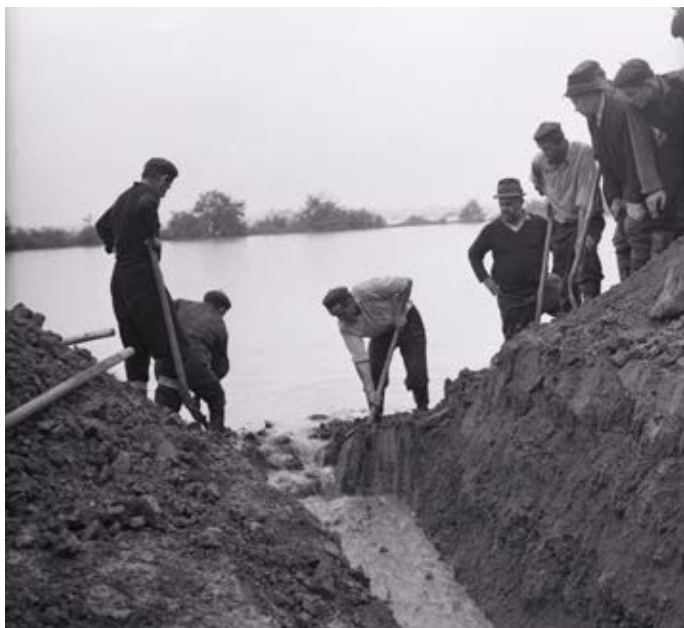
20 kép. A Tisza töltésének átvágása Olcsvaapáti fölött a Szamos vizének visszavezetésére (1970.05.18.) (A Duna Múzeum gyűjteményéből)
