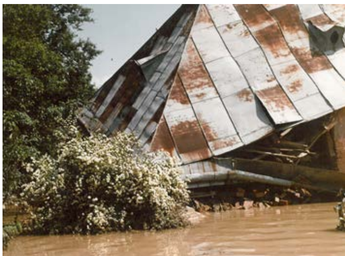
30. kép. Az árvíz pusztítása (4)
