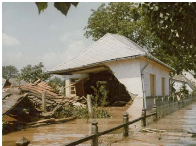
32. kép. Az árvíz pusztítása (6)
