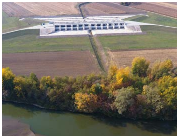
46. kép. A Szamos-Kraszna-közi tározó feltöltő műtárgya Tunyogmatolcsnál, madártávlatból
